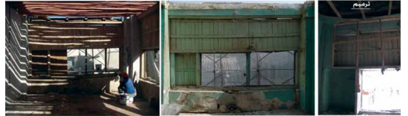
ترميم الألواح الخشبية الداخلية وتبديل النافذ
