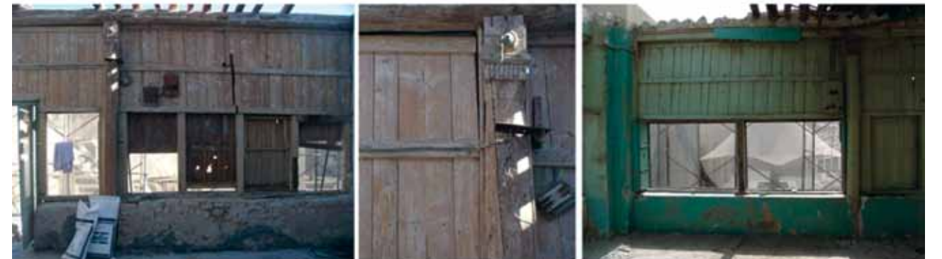
ترميم الألواح الخشبية الداخلية وتبديل النافذ
