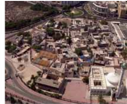
حي الفهيد أثناء الترميم
